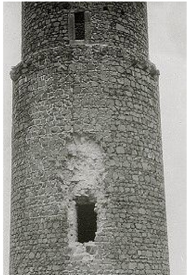
Pohled na vysypané zdivo po úderu blesku v roce 1975
